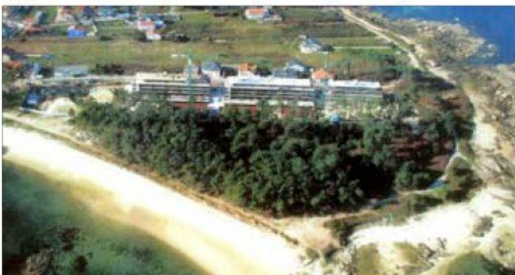
2008. El edificio ya está contruido y el ático de José Blanco es el primero del bloque de la derecha, con la mejor vista.
